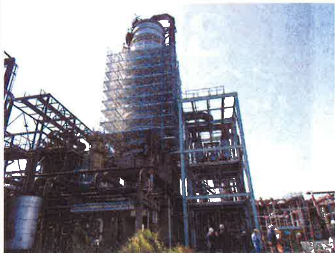
装置の4方に足場を設置(ENEOS根岸製油所)
